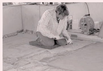
Abb. 23 Einbau des Mosaiks im Frühjahr 2005 an seinem neuen Ort bei der Firma USM.
