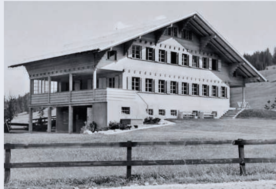
Abb. 21 Das Münsinger Ferienheim in der Saanenmöser, das 1961 in Betrieb genommen wurde.
