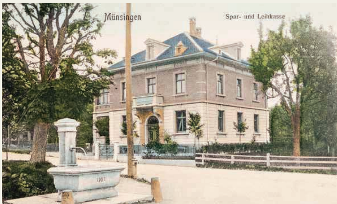
Abb. 16 Der 1902 errichtete Neubau der Spar- und Leihkasse Münsingen, heute der Einwohnergemeinde für Verwaltungsräumlichkeiten vermietet.
