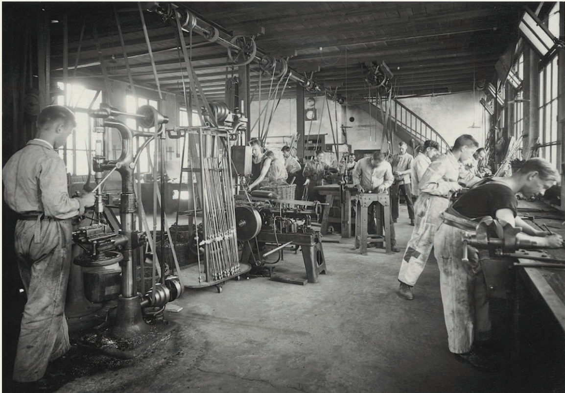
Abb. 31 Werkhalle der Firma U. Schärer Söhne um 1930. Links der Bildmitte: Halbfertige Drehstangen für die Espagnoletten.
